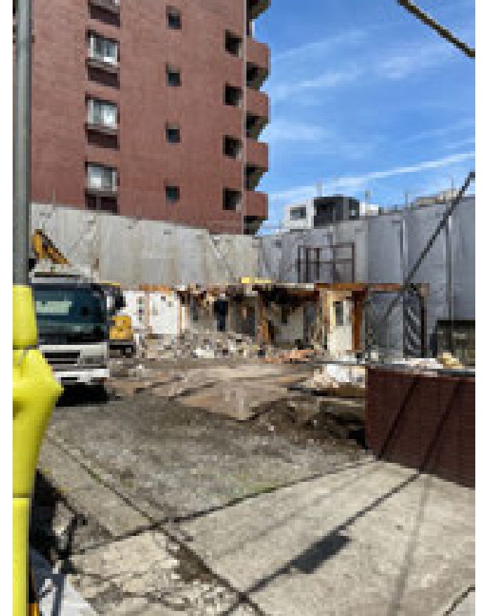
とりあえず、解体現場は押さえておく。
