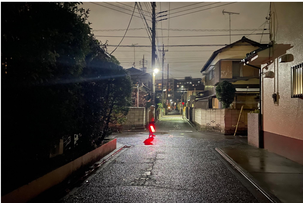
⑦ 路上での作業中、車を誘導する。
